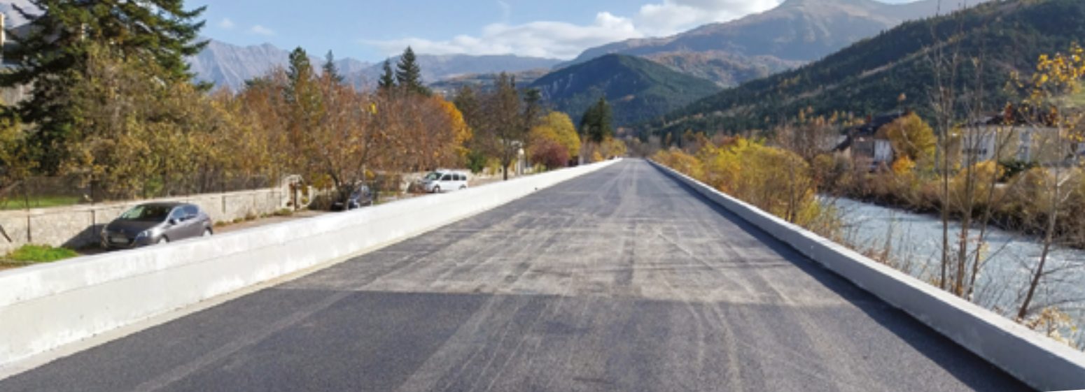
Traversée de Barcelonnette, via la RD 900
